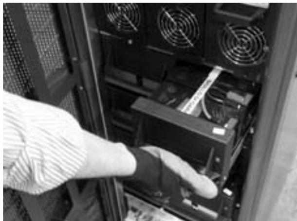
Antes de proceder com a programação do aparelho, apurar que todos os módulos presentes (inverter e/ou gavetas da bateria) estejam fechados e fixados com os parafusos específicos.
